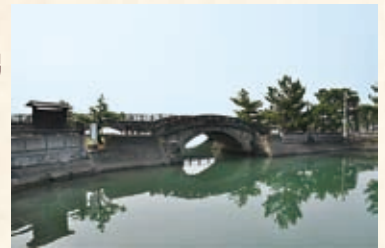
⑧ 不老橋 【和歌浦のシンボリックなアーチ式石橋】 紀州徳川家10代藩主 治宝公が隠居後、東照宮御旅所への御成道に築造。不老不死の願いがこもる。
