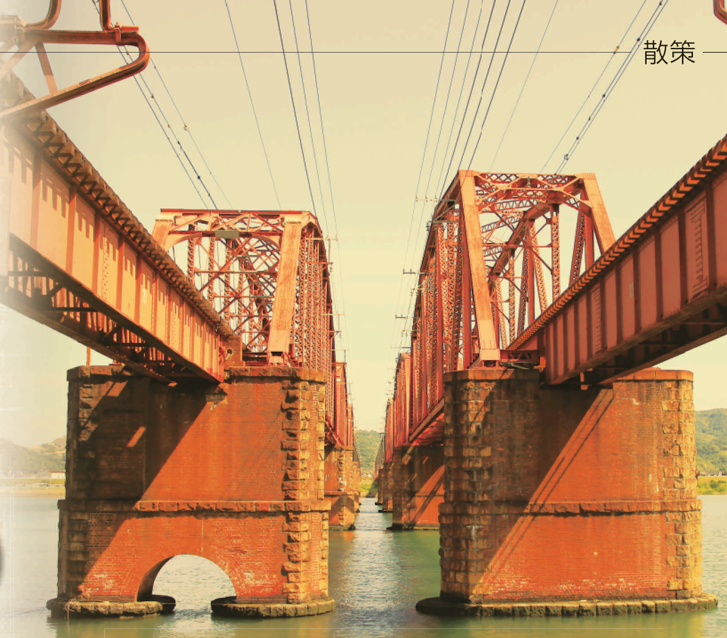
⑧南海本線 紀ノ川橋梁 《上り線 1903 (明治 36)・下り線 1922 (大正 11) 建設》 南海本線の複線化に伴い、下り線が建設された。上下線で橋脚やトラスの形状が異なっている。近代化産業遺産 (経済産業省)。
