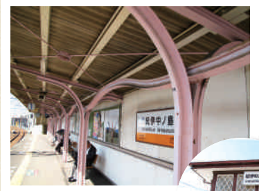
⑩ JR 紀伊中ノ島駅 《1935 (昭和10) 年建設》 モダンな斜め格子の駅舎。 旧 官営八幡製鉄所で操業当初 (100年以上も昔)に製造された古いレールが、 ホームの屋根を支えている柱や梁に使用されて いる。推薦産業遺産 (産業考古学会)。
