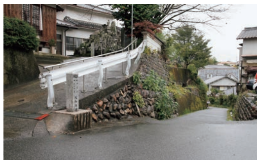
現在の黒暗嶽周辺（橋本市隅田町下兵庫）
